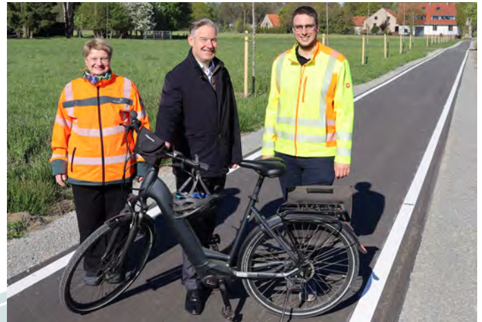
Wichtige Verbindung für den Radverkehr ausgebaut (v. l.): Kathrin Gellermann vom Landesbetrieb Straßen NRW, Bürgermeister Michael Berens und Klimaschutzmanager Moritz Pucker auf dem fertiggestellten Bürgerradweg an der Espelner Straße.
