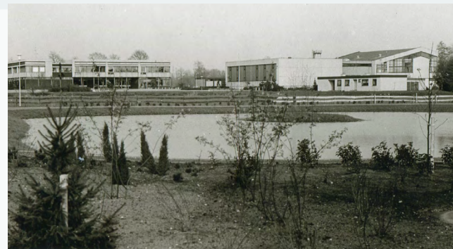
Die Aufnahme von Karl-Heinz Brake stammt aus dem Jahr 1978 und zeigt den Park Verrières, die Krollbachschule (v. l.), die Sporthalle, das Schwimmbad sowie Nebengebäude.
