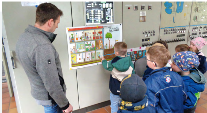
Die Kinder der Herz-Jesu-Kita lernten bei der Führung durch Kläranlagen-Leiter Klaus Schmidt die Stationen der Abwasser-Reinigung kennen.
