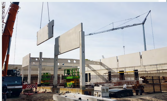
Auf der Baustelle am Sennebad geht es voran.
