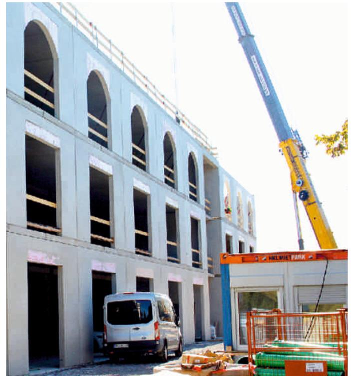
*Dreigeschossig: Die zügige Montage der Betonfertigteile ließ schnell die Dimensionen des Gebäudes erahnen.*
